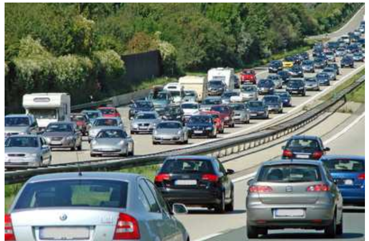
Die Verkehrsinfrastruktur muss dringend ausgebaut werden. Foto: Th. Reinhardt / pixelio.de
